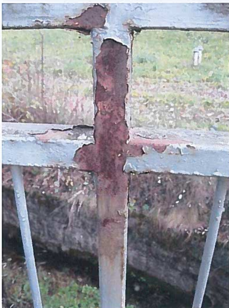
Koroze zábradlí.
