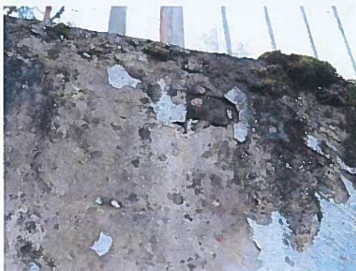
Zbytky bednění - levá římsa
