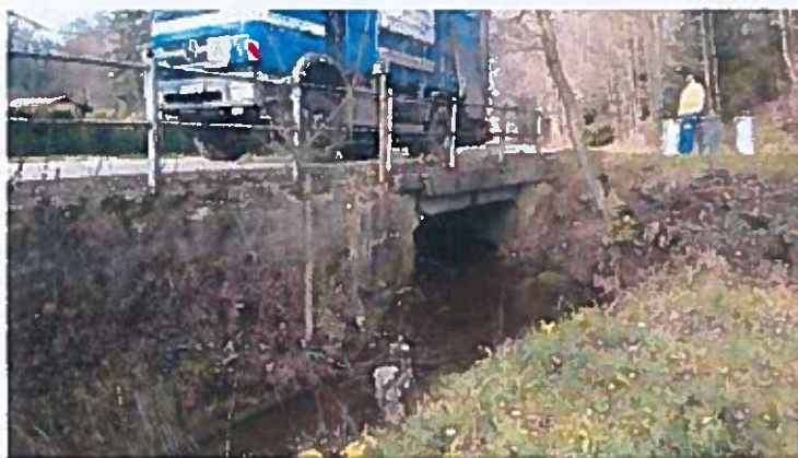
Pohled na vtokovou stranu objektu
