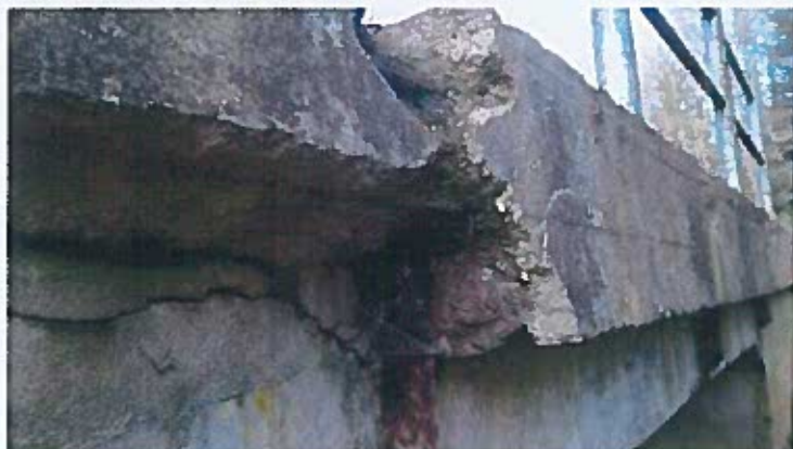
Rozpad římsy
