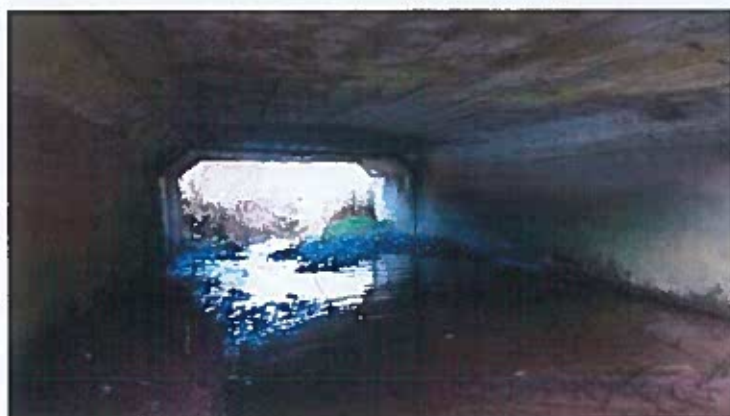
Pohled do mostního otvoru
