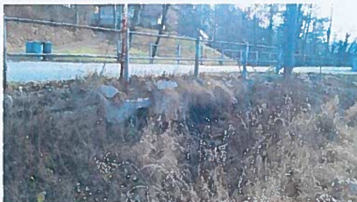
Pohled na výtokovou stranu objektu
