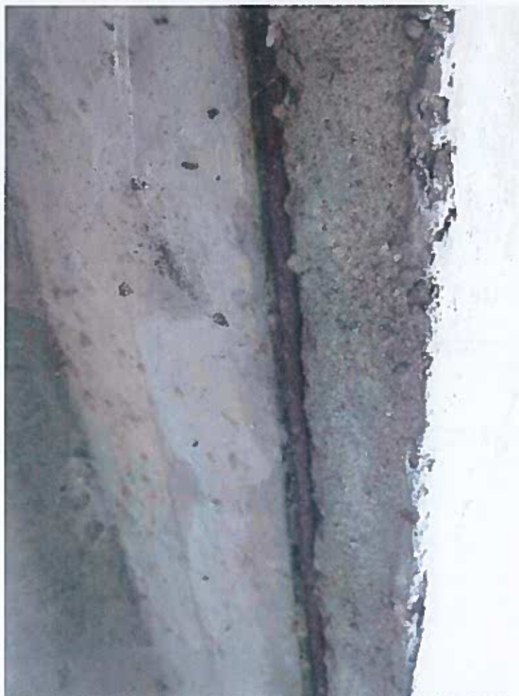
Betonářská výztuž v místě okapničky - parvová římsa.
