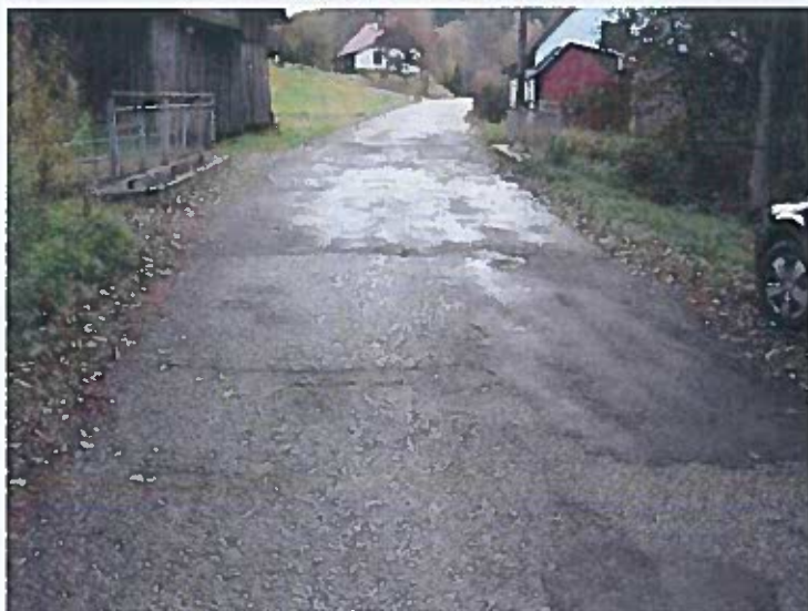
Pohled na most ve směru staničení. U na styku vozovky a říms jsou patrné nánosy a listí.
